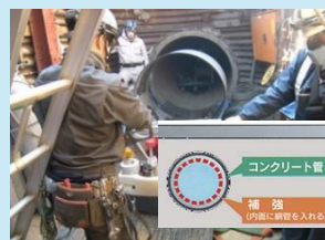
例：管路の耐震補強
