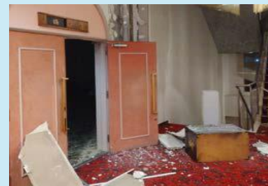
【被災したホテル館内】
