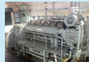
例：自家発電機の整備
